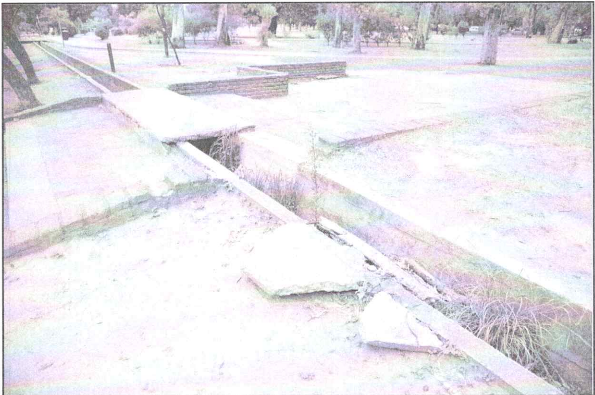
Fotografía N°17- Se deberá demoler la escalera y reconstruir en ese espacio el talud de tierra según detalle D1.
