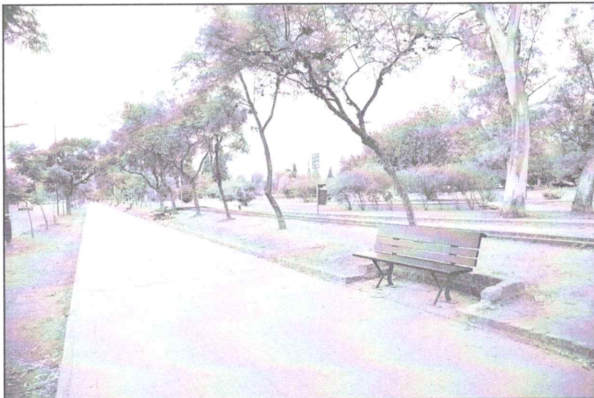
Fotografía N°18- Erosión del suelo entre vereda y acequia. Se deberá reconstruir el perfil del talud con vegetación según detalle D1 y fotografías antiguas.
