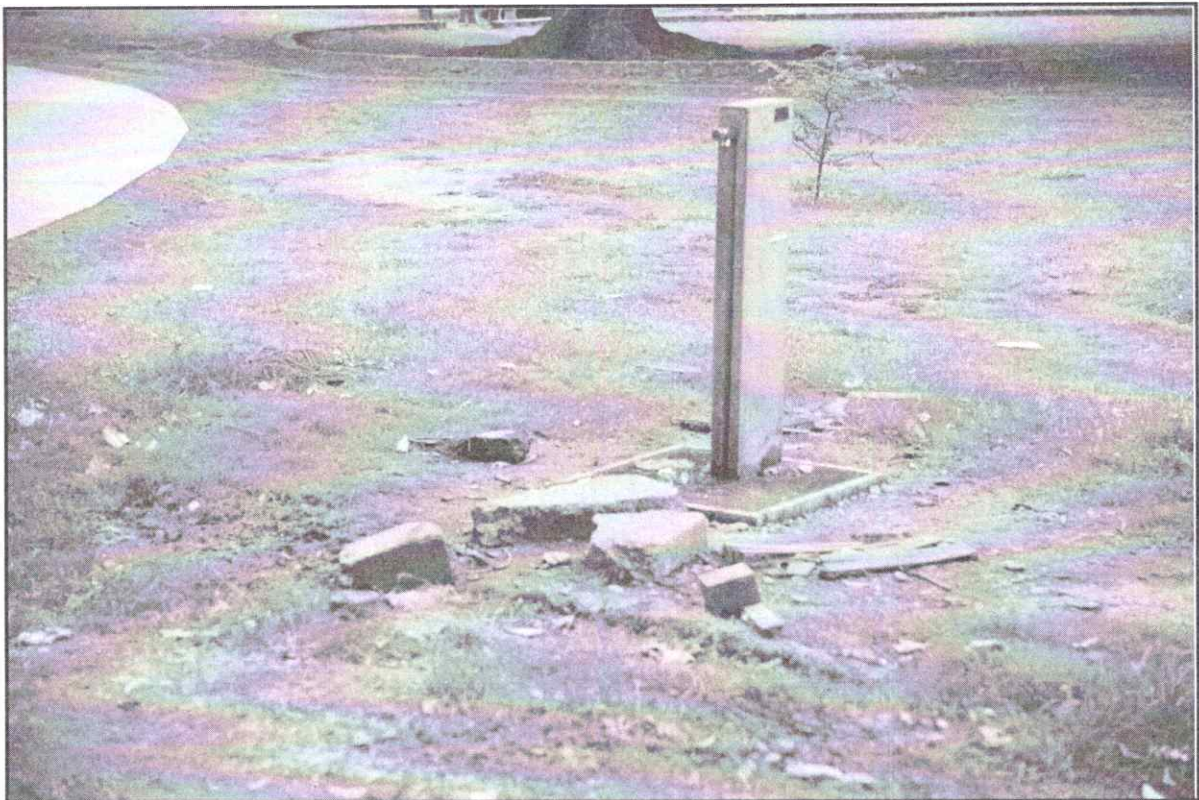
Fotografía N°8- Se deberán extraer los bebederos existentes, sin anular la instalación de agua.
