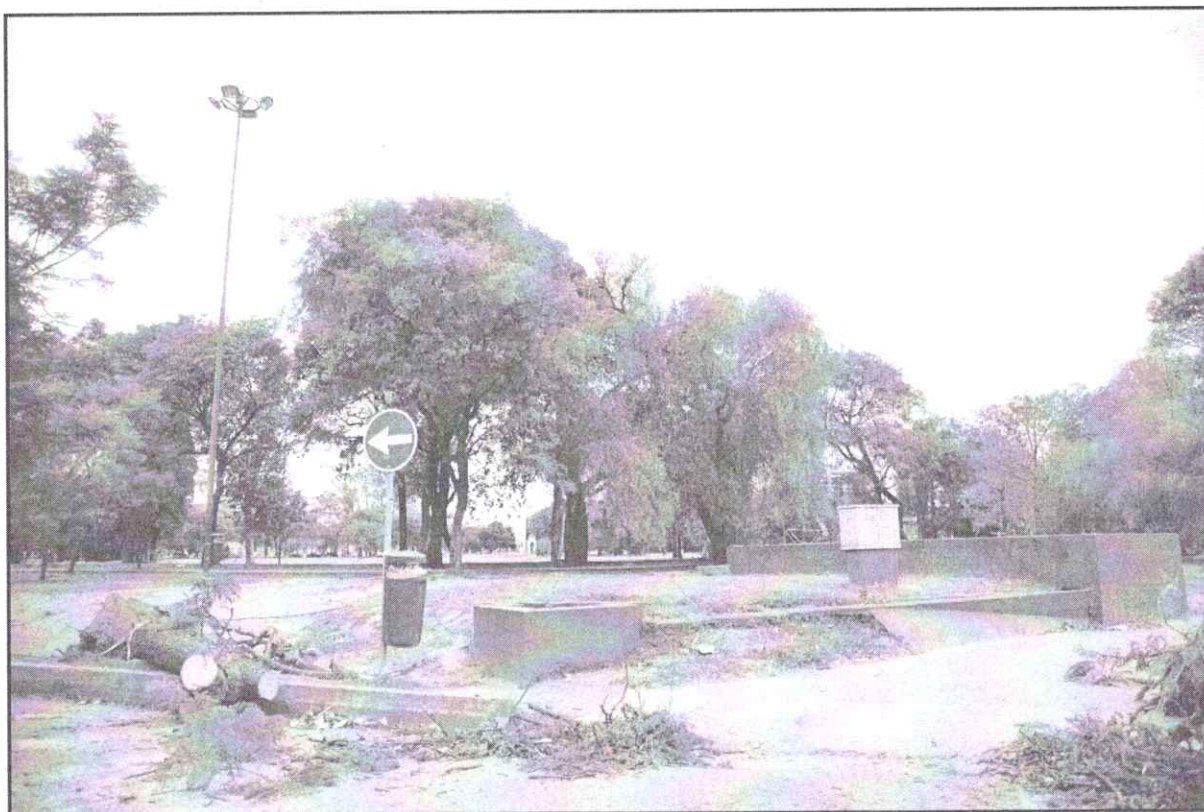
Fotografía N°3- Se trasladará el tablero eléctrico verde, el cartel de señalización vial y se demolerá lo indicado en plano de relevamiento, a fin de asegurar una conexión más cómoda en la esquina y disminuir la contaminación visual sobre la avenida.
