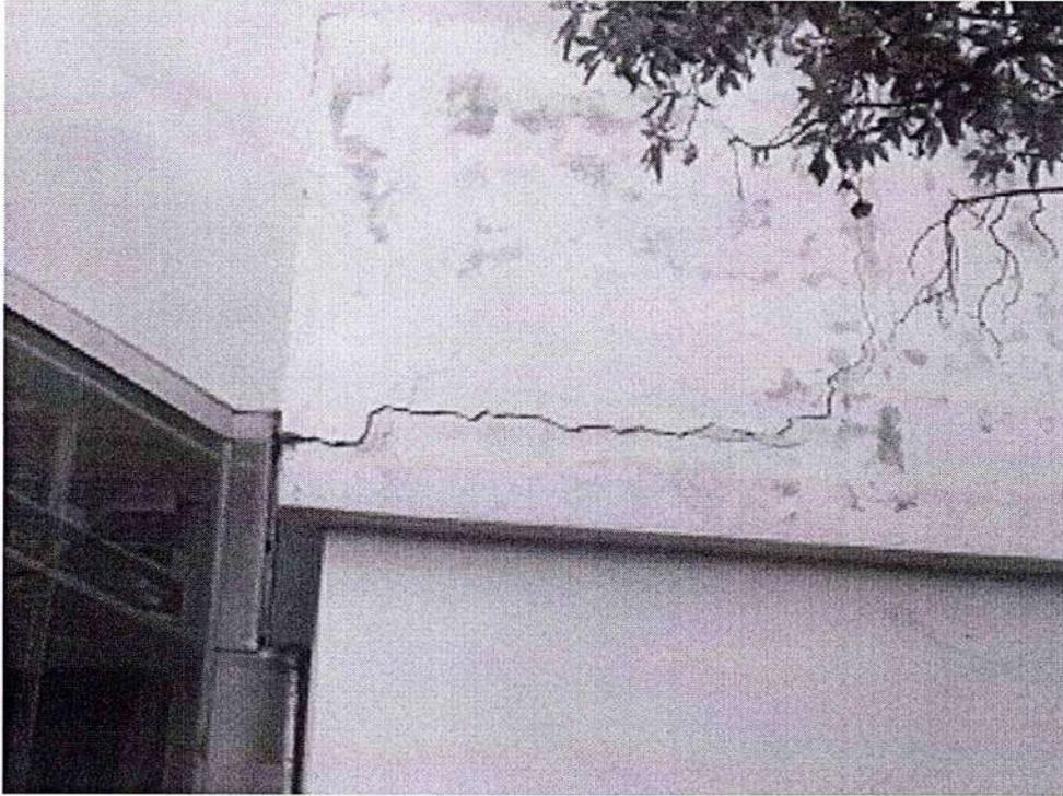
5-FISURA PARAPETO QUE INDICA EL SENTIDO DEL ASENTAMIENTO HACIA ESTACIONAMIENTO Y HACIA CALLE DE FRENTE.
