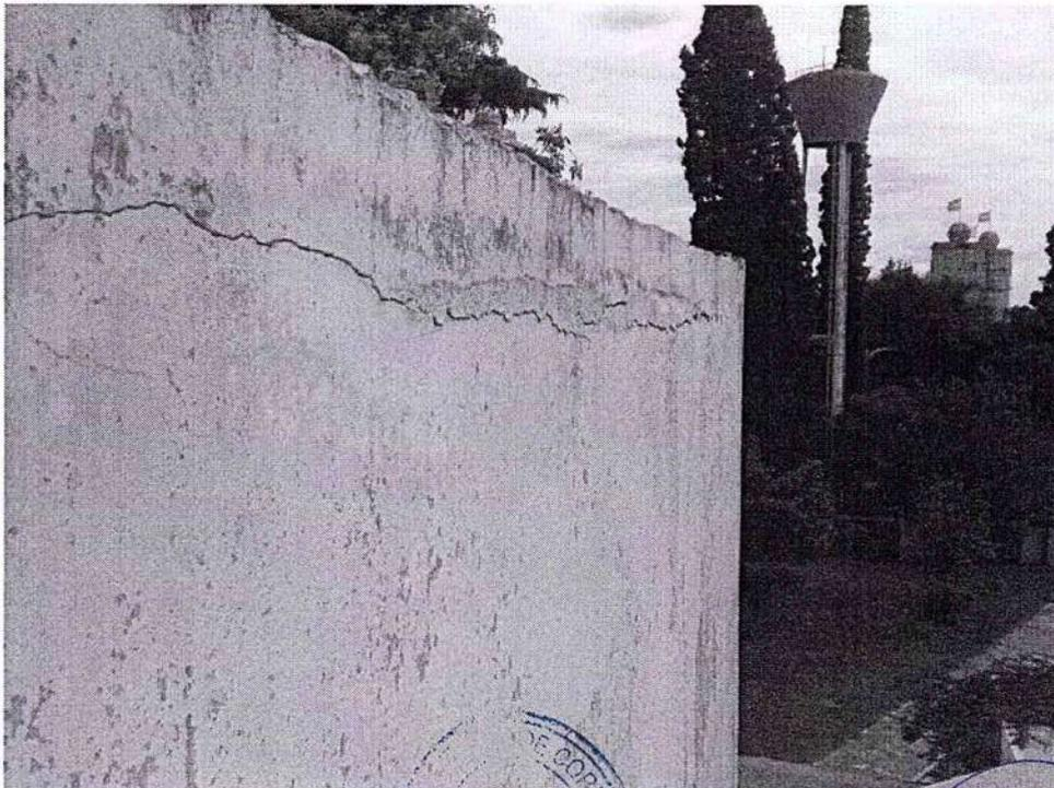
6-VISTA MURO CONTENCIÓN DE TANQUES CON FISURAS 1.
