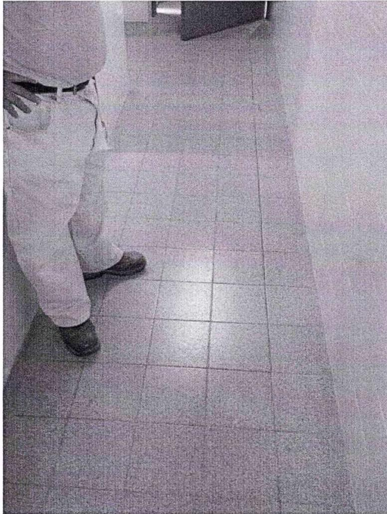
14-FISURA PLANTA BAJA EN PISO INDICA GIRO DE BLOQUE HACIA COCHERA IZQUIERDA.
