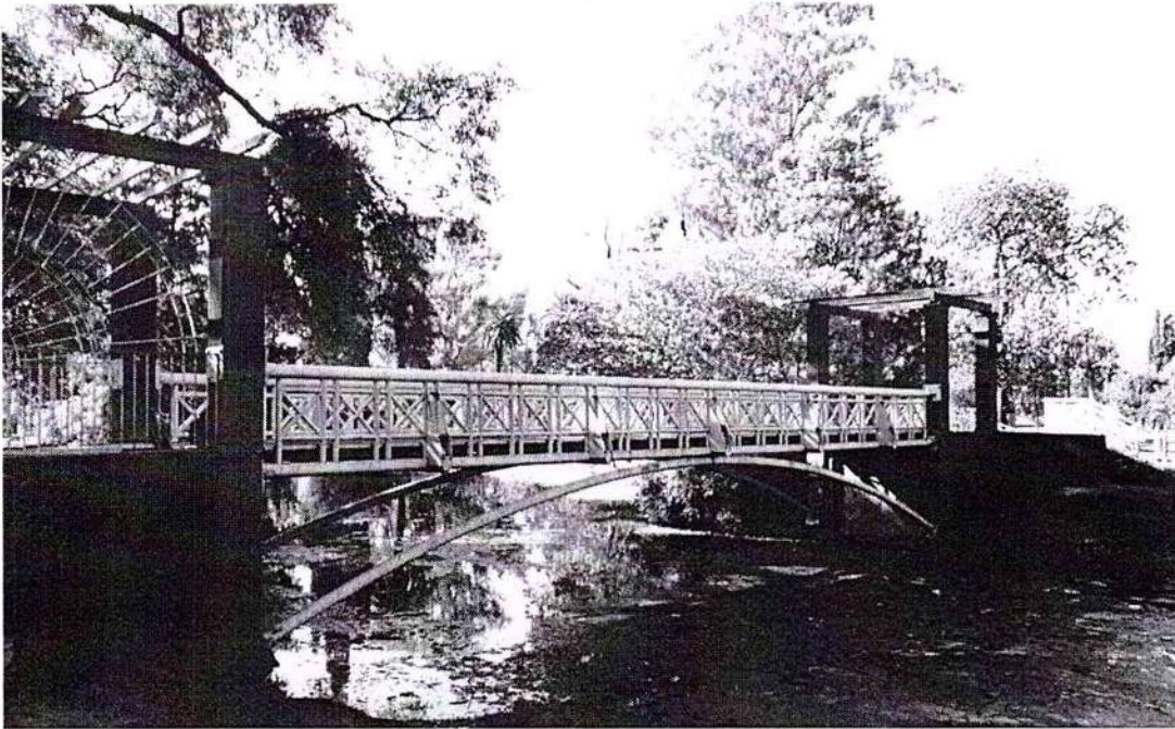
Fotografía N° 18- Puente de la isla La Encantada. Posee intervención de colores en elementos de hormigón. Se observa la estructura en arco vinculada a la baranda que colabora con la misma función.
