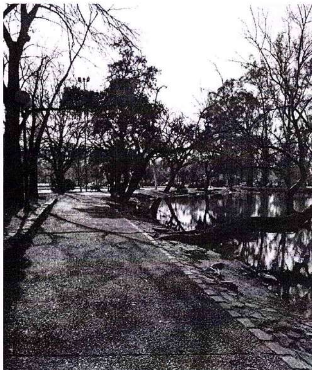
Fotografía N° 24- Los bordes en pendiente de piedra sobre la laguna presentan faltantes de distinto tamaño.
