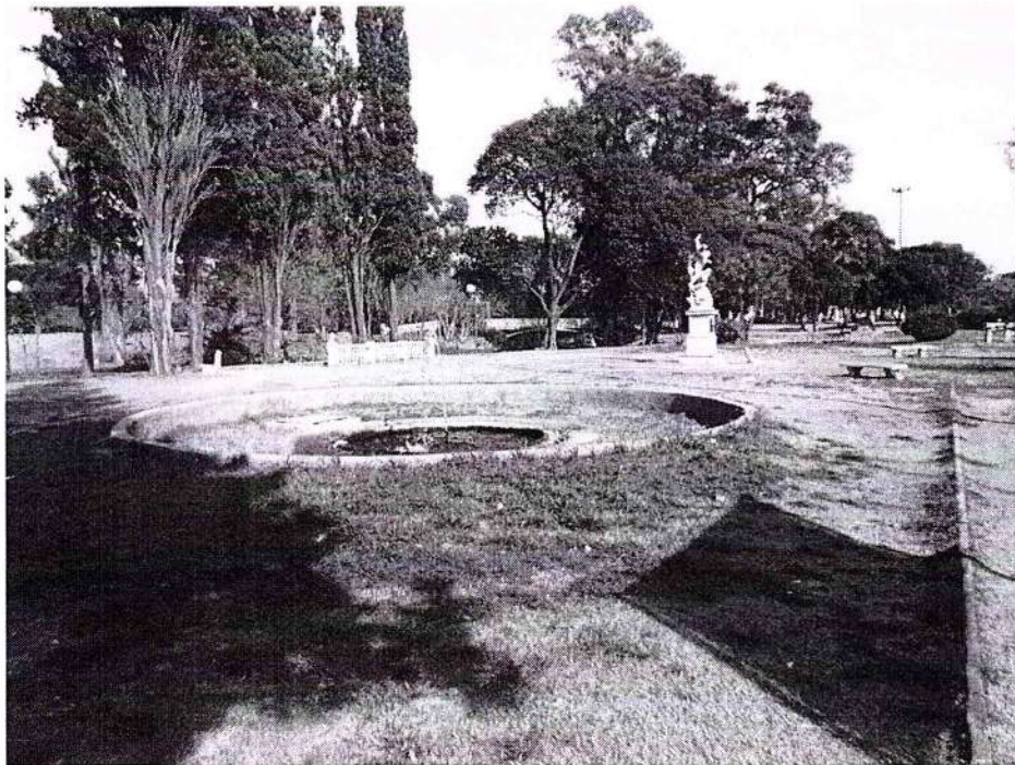
Fotografía N° 4 - La vegetación del jardín ha desaparecido. Se pueden reconocer los caminos internos por el cordón de ladrillo que marca su perímetro. La vegetación de telón de fondo en los 3 lados posee muchos faltantes, así como el muro curvo de ingreso.
