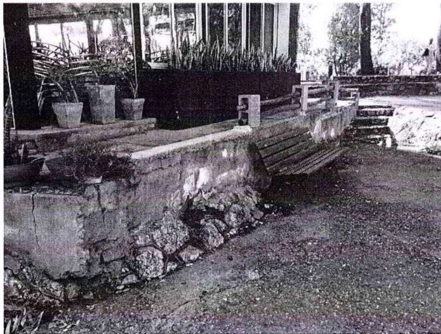
Fotografía N° 28- Agregados posteriores sin calidad estética o constructiva sobre elementos de piedra originales en muros y escalinata.
