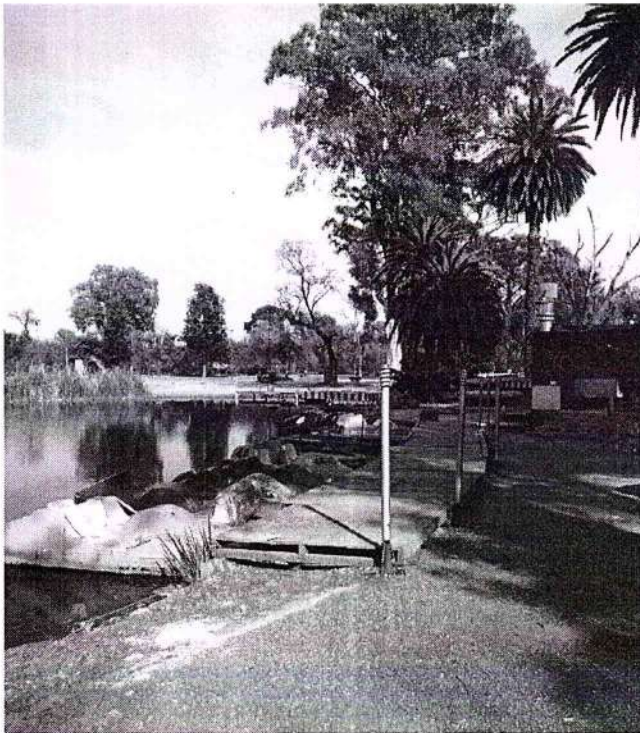
Fotografía N° 23- Plataforma de madera colocada sobre borde original de la laguna. En esta zona se observan placas símil fibra de vidrio recubiertas con algún tipo de mortero, representando un peligro para los peatones.
