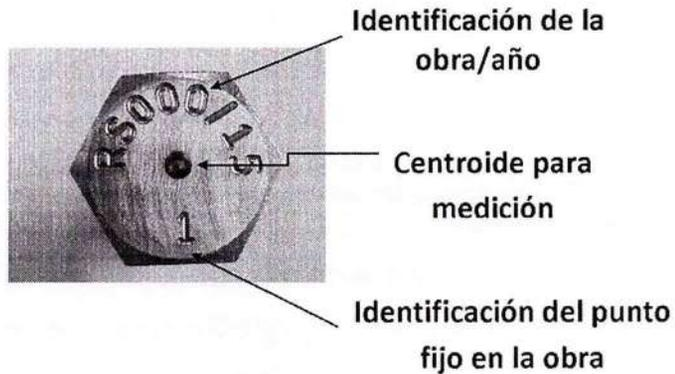
*Estos puntos fijos conformarán la red Municipal de referencia altimétrica para obras de infraestructura y cuyos nodos serán identificados mediante datos monográficos de ubicación e identificación.*
